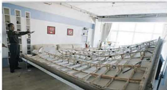
展示厅的吊顶脱落
